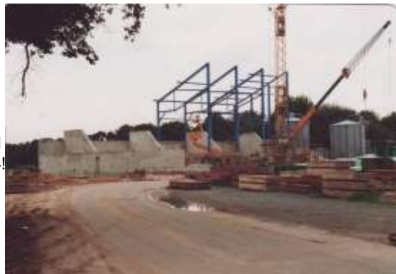
Bau der Aufbereitung 1994
